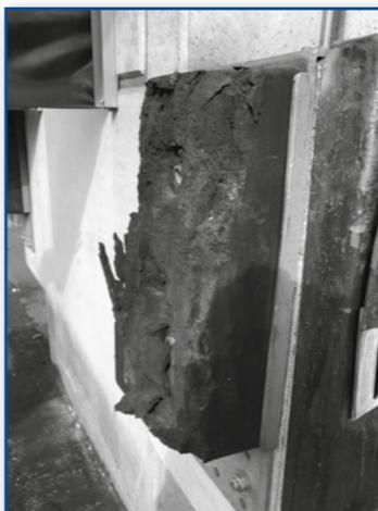
Ein sehr oft eingesetzter Rampenpuffer gerade bei der Erstinstallation ist der Vollgummipuffer bzw. Gummihohlkammerpuffer. Auf Grund der eingesetzten Materialien bietet er eine gute (Vollgummipuffer) bzw. sehr gute (Hohlkammerpuffer) Schutzfunktion für das Gebäude (Diagramm Linie 1, nächste Seite). Allerdings lassen die Lebensdauer (starker Abrieb) und die Servicefreundlichkeit insbesondere bei der Demontage zu wünschen übrig.
